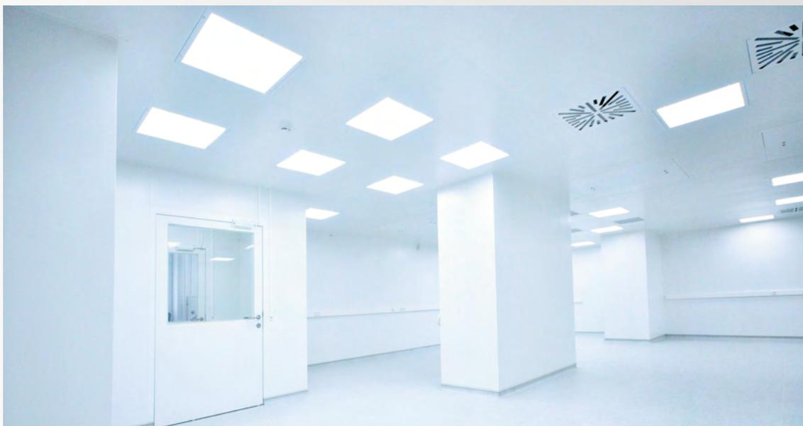
Светильники воздухонепроницаемые и обеспечивают герметичность потолка. Цвет светильников одинаков с цветом потолка. Корпус выполнен из оцинкованной стали порошковой окраски. Пускорегулирующая аппаратура установлена внутри корпуса светильника. С нижней стороны светильника установлена рама с рассеивателем света, легко открываемая для доступа к внутренним элементам. Количество светильников определяется светотехническим расчетом.
