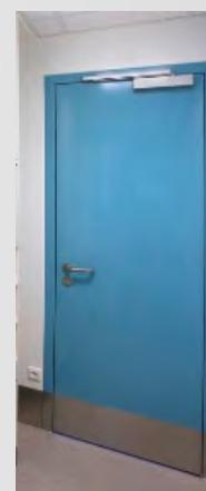
Стандартные двери оснащаются специальными дверными петлями, которые полностью интегрированы в раму, и с механическими доводчиками.
