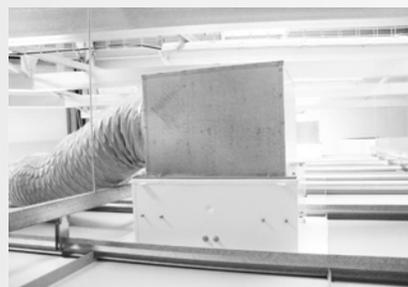
Воздухораспределители выпускаются с разными размерами корпуса в зависимости от размера фильтра HEPA.
