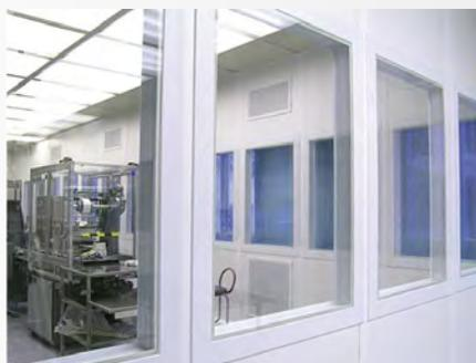
Система остекления представляет собой двухстороннее остекление, где стекло устанавливается заподлицо с поверхностью панели.
