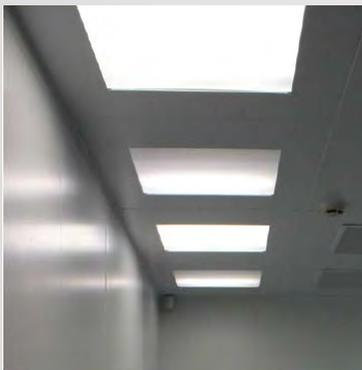
Несущий (проходной) потолок для «чистых помещений» представляет собой герметичную потолочную конструкцию с повышенной несущей способностью.
