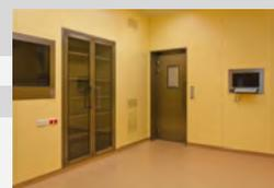
Перегородки состоят из несущей решетки, которая собирается из стальных конструктивных профилей. Металлическая облицовка состоит из корпуса, наполнителя SDK и клапана. Корпуса изготовлены из листовой стали в соответствии с требованиями проекта. Усиление панели выполнено из гипсокартона толщиной 12,5 мм и приклеено к корпусу. Закрылки изготовлены из того же материала, что и корпуса.
