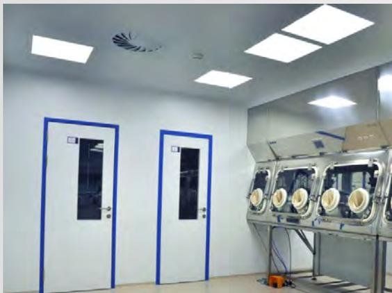
Люминесцентные светильники **For Clean Light** используется для освещения внутренних помещений с контролируемым классом чистоты. Светильники устанавливаются в лёгкие металлические потолки и являются воздухонепроницаемыми, обеспечивая тем самым герметичность всего потолка. Отделка поверхности и цвет светильников совпадает с цветом потолка.
