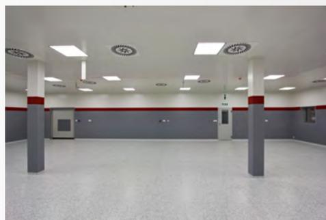
Преимущество multifunctional системы заключается в ее универсальности. Дизайнерское решение позволяет легко интегрировать внутреннее оборудование и простой демонтаж облицовочных панелей и элементов с функциональной стороны помещения без пыльных процессов. Несущая конструкция системы позволяет легко устанавливать электропроводку, воду, газы и другие среды.
