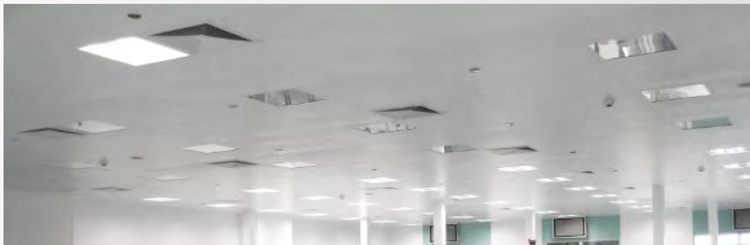
На случай возникновения избыточного давления в помещении потолок защищён от приподнимания. Конструкция подвесного потолка позволяет встраивать в неё светильники, воздухотехнические насадки, фильтрационные насадки PUROFIL, сервисные и остекленные кассеты.
