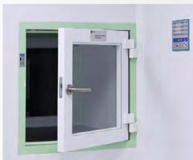
Для передачи небольших предметов и материала между помещениями с различными классами чистоты можно использовать передаточный шлюз (кабину), установленный прямо в перегородочную панель.
