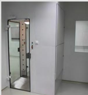
Очистка персонала осуществляется подачей рециркуляционного воздуха под высоким напором через распределительные боковые отверстия. Воздух фильтруется HEPA фильтрами, установленными на потолке кабины шлюза.
